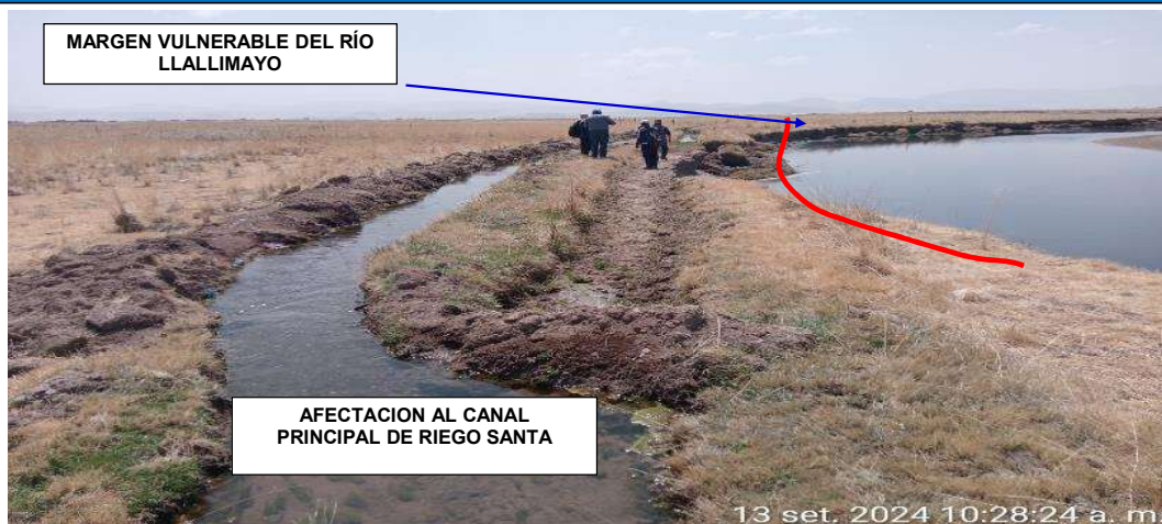
FIGURA N°01: TRAMO CRÍTICO EN EL RÍO LLALLIMAYO RIESGO DE COLAPSO DEL CANAL PRINCIPAL , EN EL SECTOR CENTRO PAYLLA, DISTRITO DE UMACHIRI, PROVINCIA DE MELGAR - PUNO.
