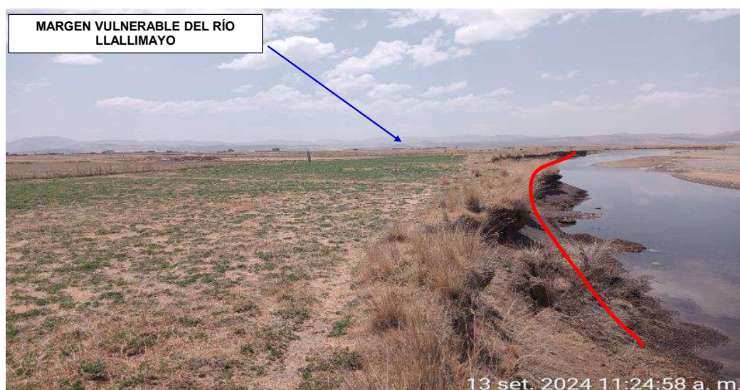
FIGURA N°03: AREAS AGRICOLA PROPENSAS ANTE UNA CRECIDA DEL RÍO LLALLIMAYO Y LA EROSION EN LA MARGEN IZQUIERDA EN EL SECTOR DE SANTA ASUNCION.
